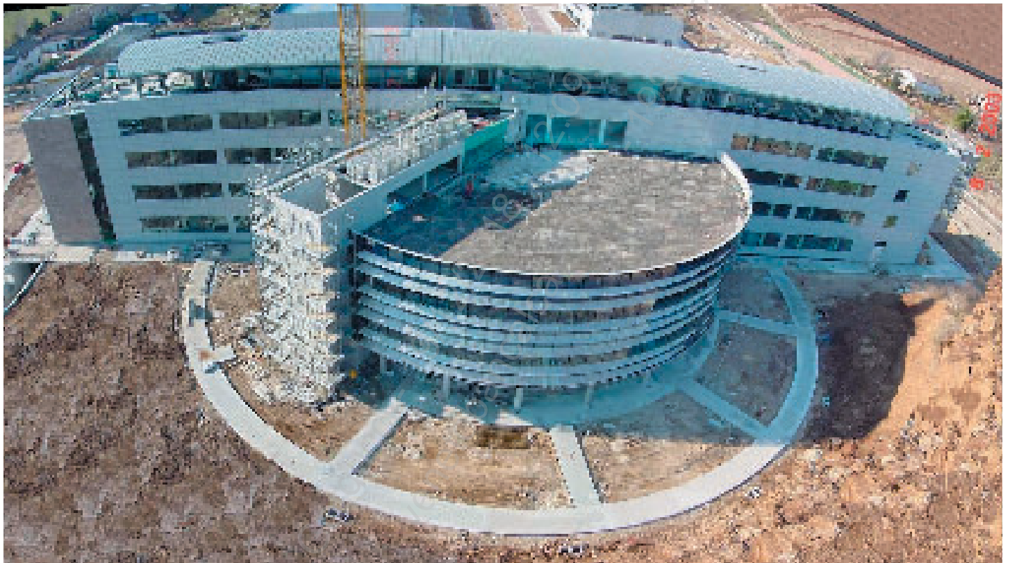
PANORAMICA DEL NUOVO CENTRO SERVIZI DI VENETO BANCA, IN COSTRUZIONE LUNGO LA STATALE FELTRINA A SUD DELL'ABITATO DI MONTEBELLUNA.
